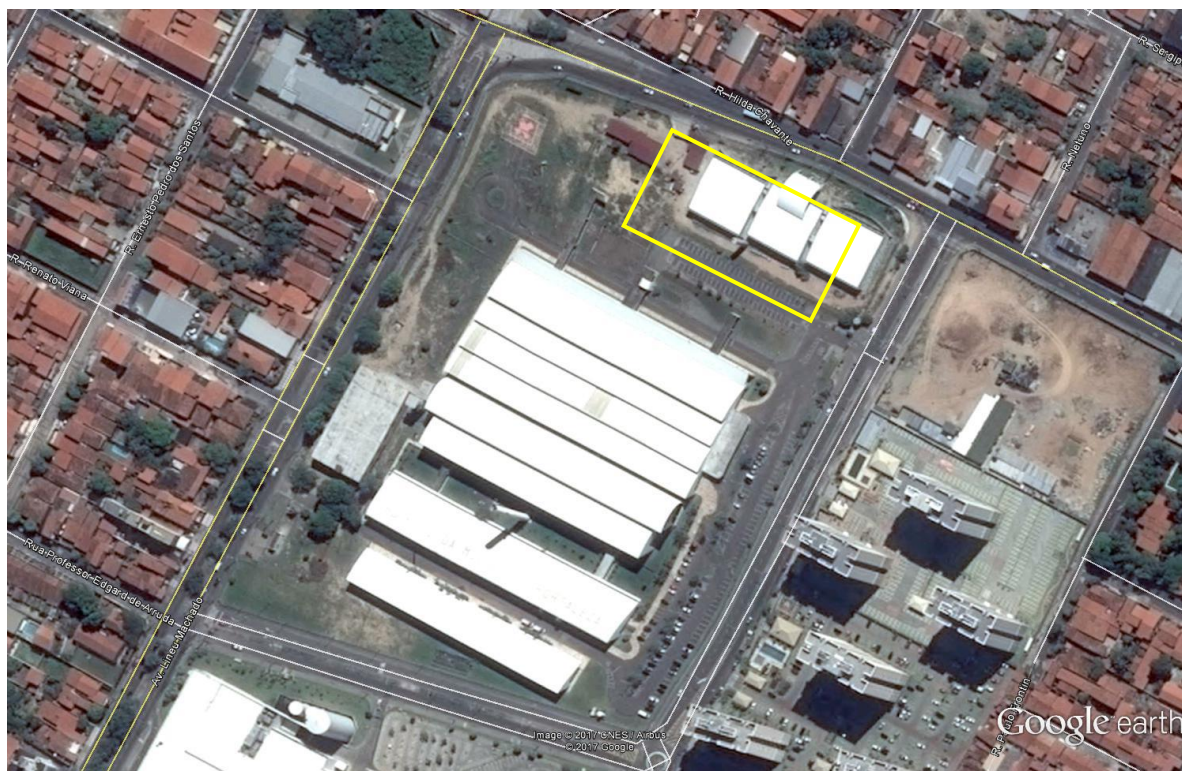
Imagem 1 – Vista aérea das instalações atuais da Policlínica do Hospital da Mulher - Fonte: Google Earth
